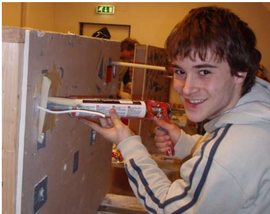
Bildet er tatt i forbindelse med en praksisoppgave der lærlingene selv skal velge riktig produkt, fysisk tette en gjennomføring i en gipsvegg og utarbeide dokumentasjon av denne.
