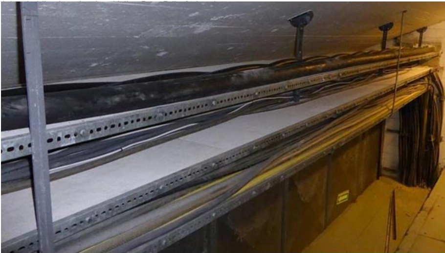
Kabelbro med asbestplater (eternitt) som underlag for kablene. Foto: Eriksen HMS AS
