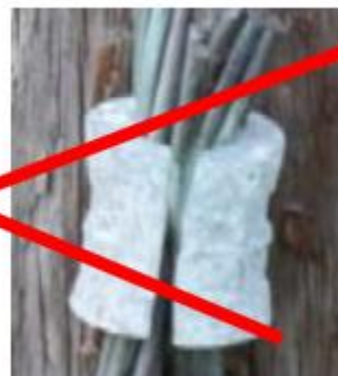
Figur 1 - H- press og Cadweld/termittsveis med god kvalitet. Lite luft
